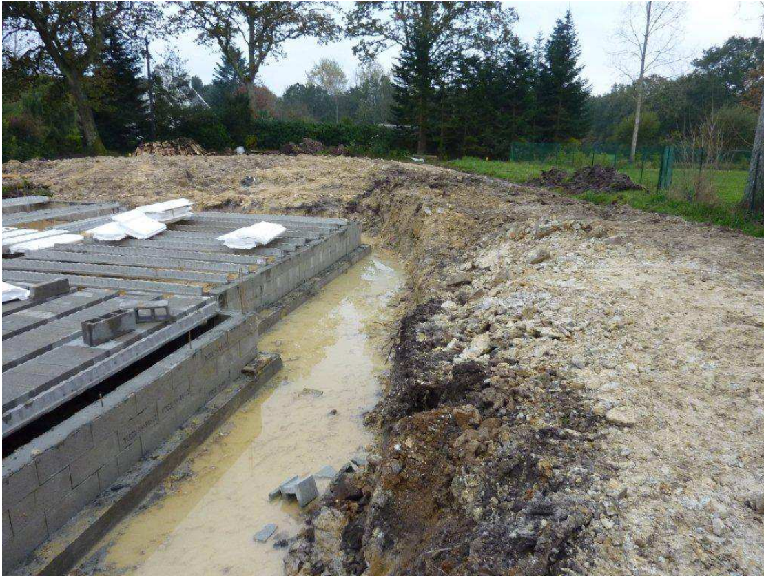
Photo 12 : Zone humide remblayée pour construire à Gouesnac'h.
