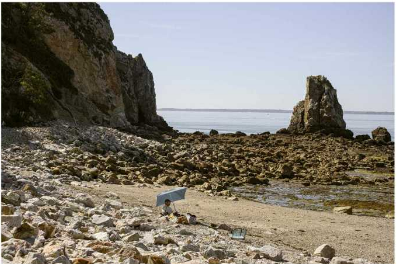
Sur la plage du Porzic, où des pans entiers de falaise se sont effondrés. A Morgat, dans le Finistère, le 12 juillet 2022. PHOTO: J. LEQUERRANT / POUÏVIEZ-DIZOLEN
